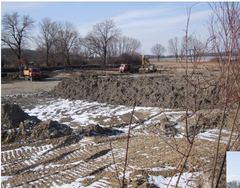
Fotografie z února 2012 Oprava a odbahnění rybníka Šejba
